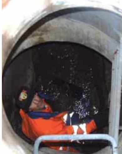
Handreinigung in der Kanalisation.
