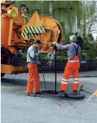
Kanalreinigung mit Spülfahrzeug.
