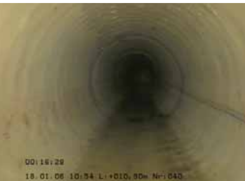
Mit einem Inliner saniertes Rohr.
